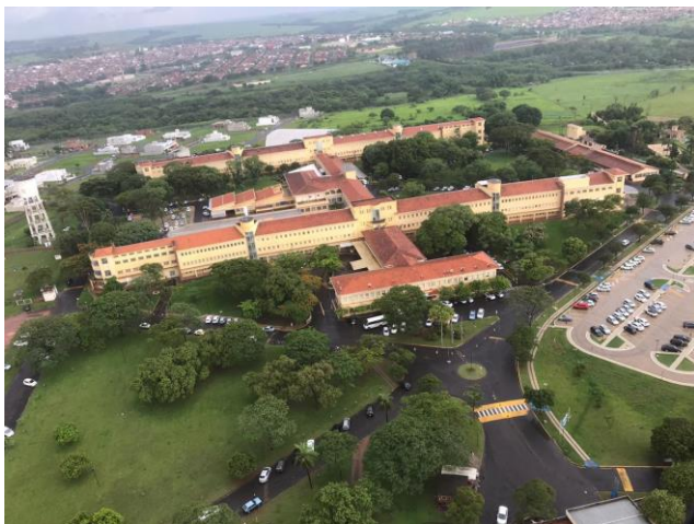
Hospital Emílio Carlos - Campus Sede da UNIFIPA
